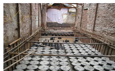
Ảnh: Công nghệ TBS áp dụng tại công trình số 32 Lò Sũ, Hà Nội
